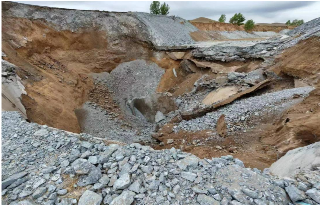
图 5 事故现场情况图
