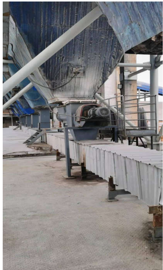
螺旋输送机北侧照片
